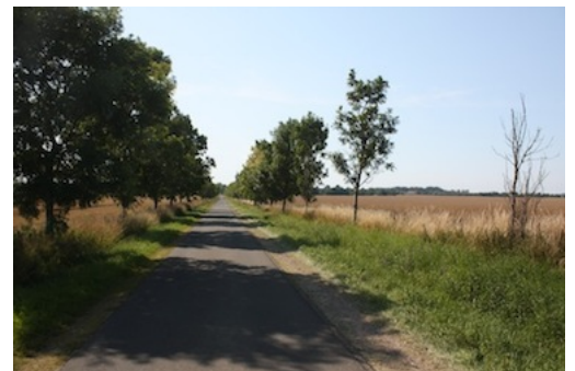
Die gleiche Straßenbreite wurde einmal geteert und rüttelt daher weniger. Straße zwischen Altenkirchen und Kap Arkona.
