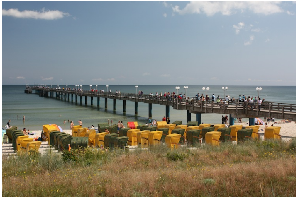
Der Anlegesteg, wie er sich heute zeigt - nach oben
