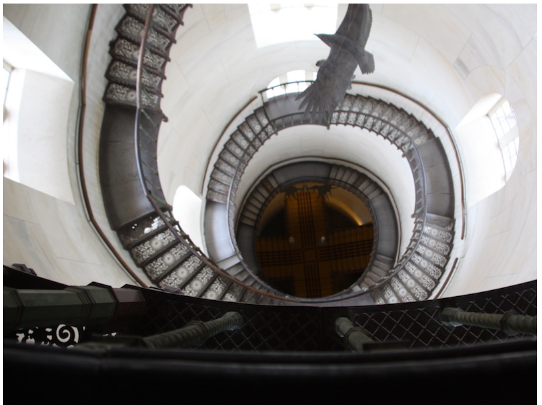
Die Treppe führt ca. dreißig Meter innen hoch. - nach oben
